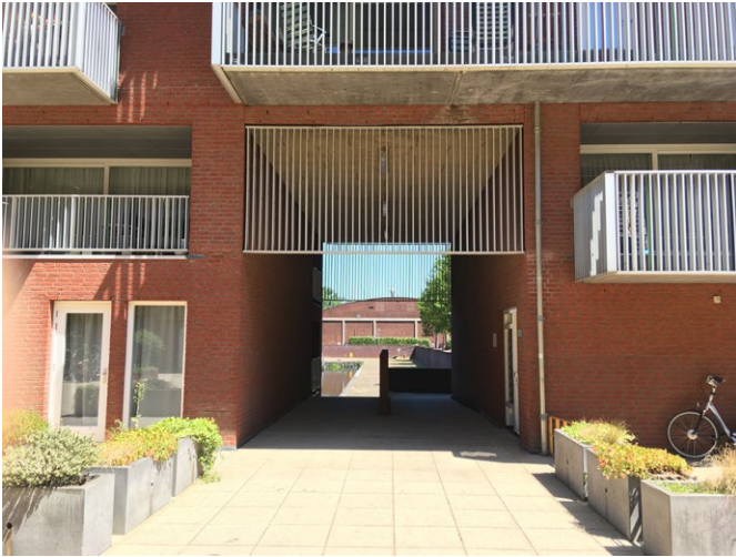
Onderdoorgang bouwblok, splitsing route
