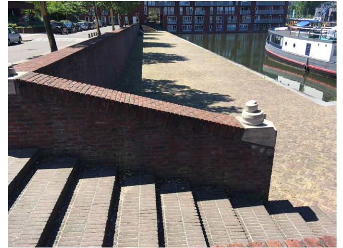
Oriëntatie trap niet in lijn met route
